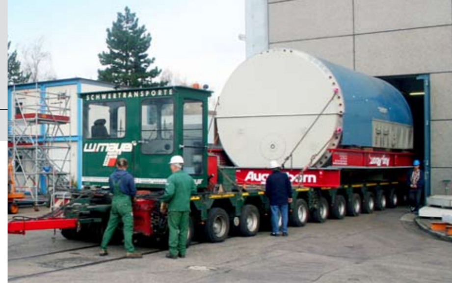
Abtransport des Generators
